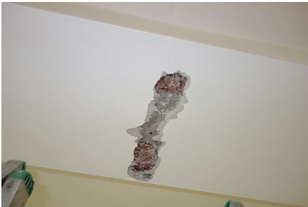
Sonda S02 - překlád nad chodbou 2np - potvrzeny 2 ocelové I nosníky - I180
